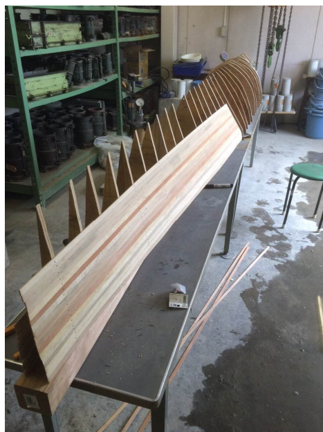
②外枠の施工、型枠完成へ
