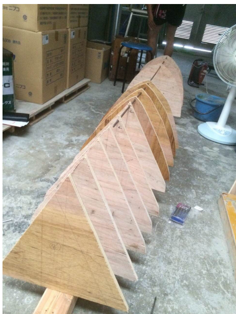
①断面の型枠配置と固定
