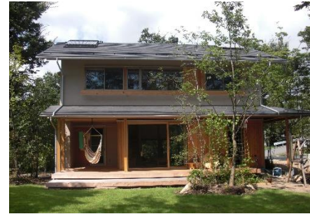
現代版土壁住宅
