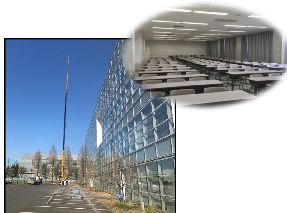
5号館空調更新
